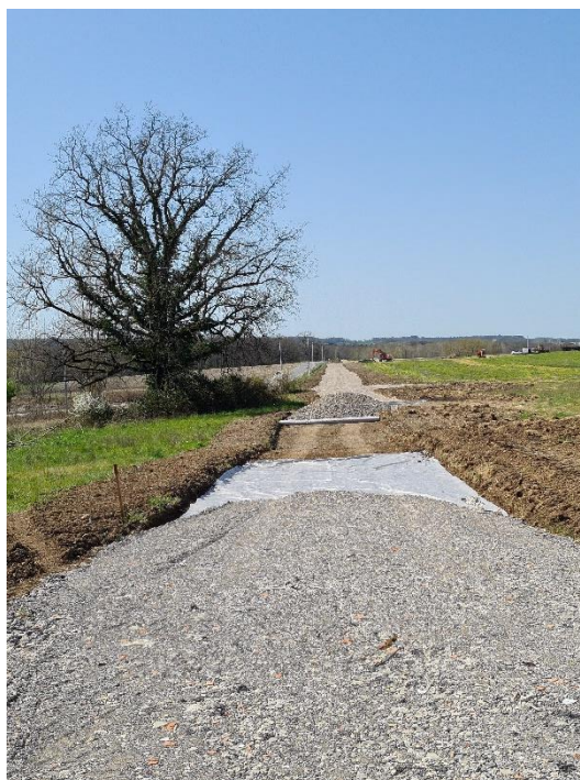
Figure 4 - Mise en place géotextile et GNT
