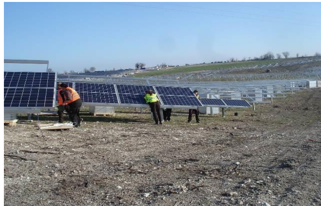
Figure 13 - Pose des modules, centrale solaire Cahors (46)
