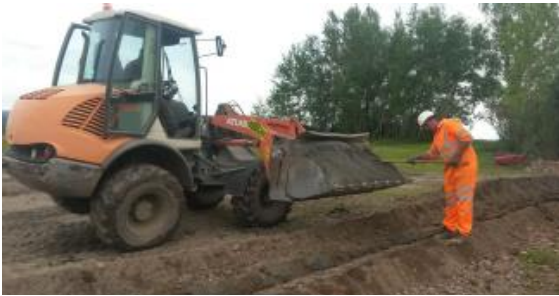
Réalisation de tranchée pour enterrement des câbles
