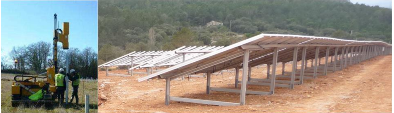
Figure 10 - Battage des pieux / Pose des structures support à pieux vibrofoncés
