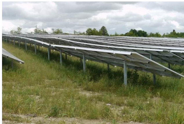
Revégétalisation, 1 mois après travaux, centrale solaire de Cahors (46)
