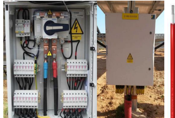
Boîte de jonction et câble de liaison module-boîte
