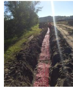
Tranchée avec grillage avertisseur
