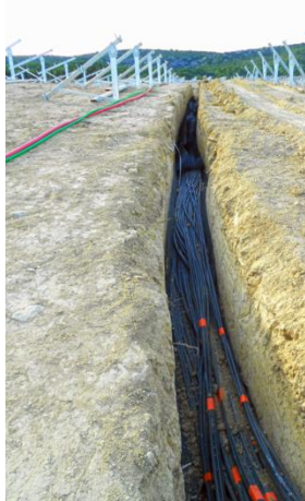
Enveloppe de protection pour câble souterrain HTA Rockshield
