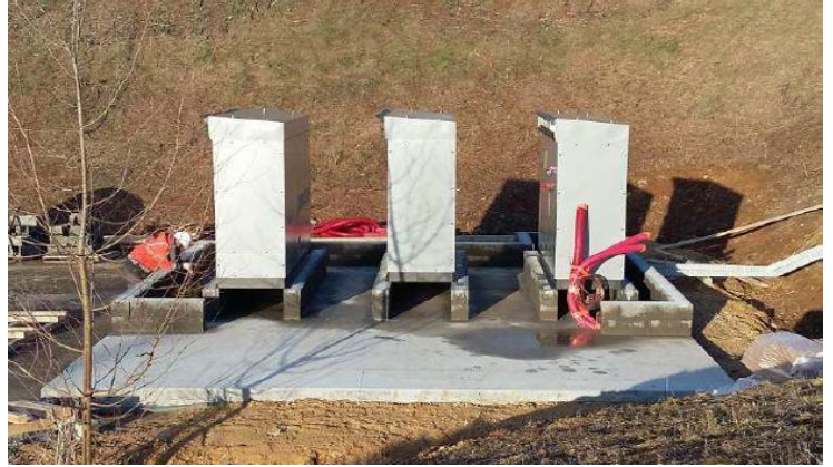
Poste de transformation en construction (2 onduleurs, 1 transformateur et enveloppe béton à venir)
